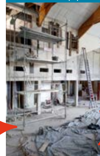
Les travaux de la salle polyvalente
