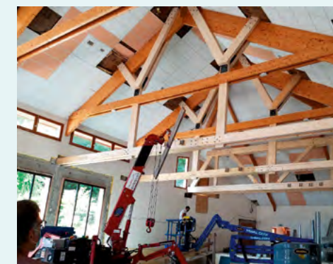
JUIN 2020 Pose de l'assure bois qui supportera le faux plafond
