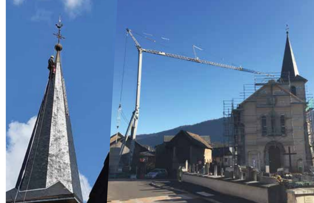
Rénovation de la toiture de l'église et pose d'une nouvelle croix.
